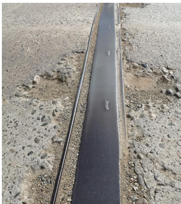
Figura 3.7: Cantonera de placa deslizante en puente Pasarela La Laguna. Fuente: Propia del autor en inspecciones realizadas, 2021.
