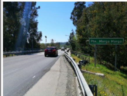
vista general puente Marga-Marga
