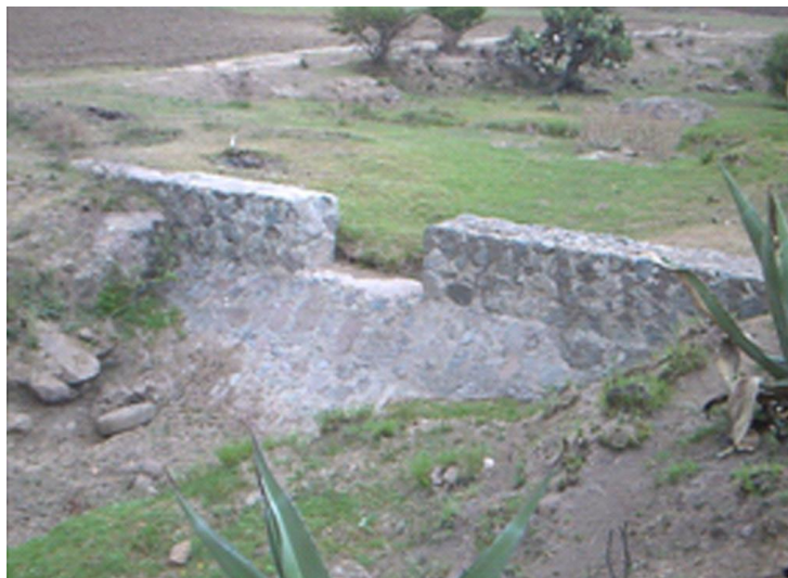
Figura 20. Disposición de presas de mampostería (SAGARPA, 2009).
