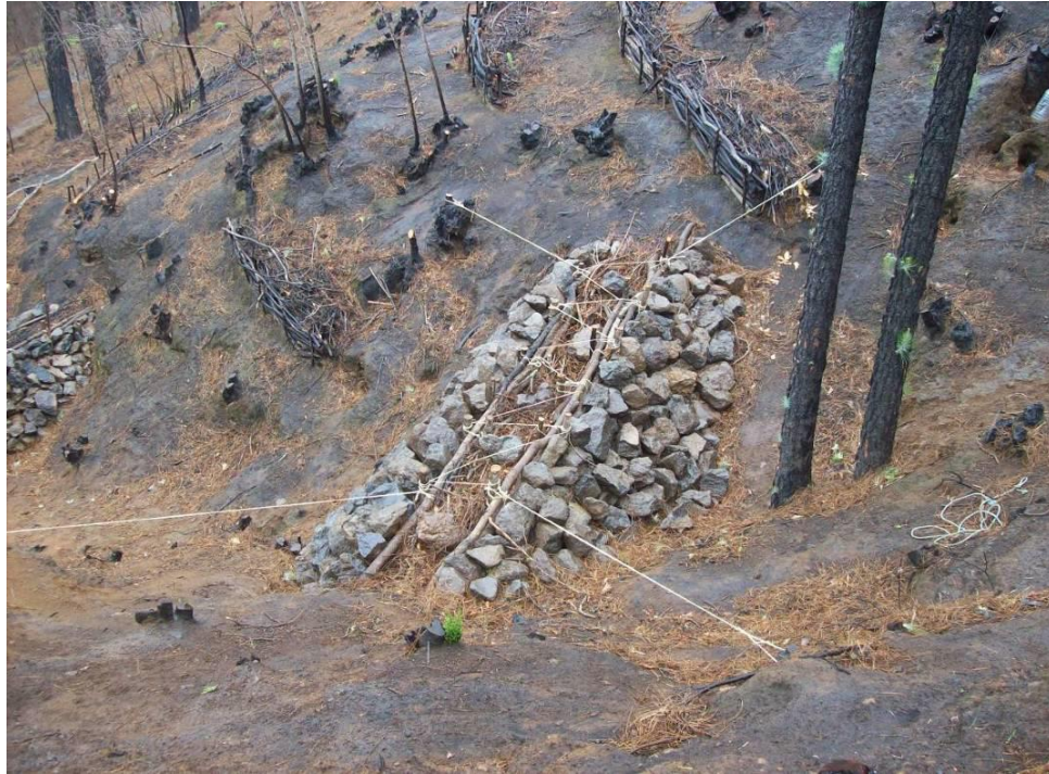
Figura 22. Disposición de dique de biomasa residual (Caballero et al. , 2009).
