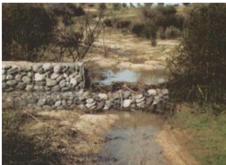
Figura 16. Disposición de dique de estructuras gavionadas (CONAF, 1998).
