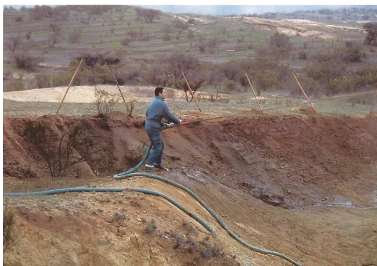
Figura 52. Implementación de hidrosiembra.
