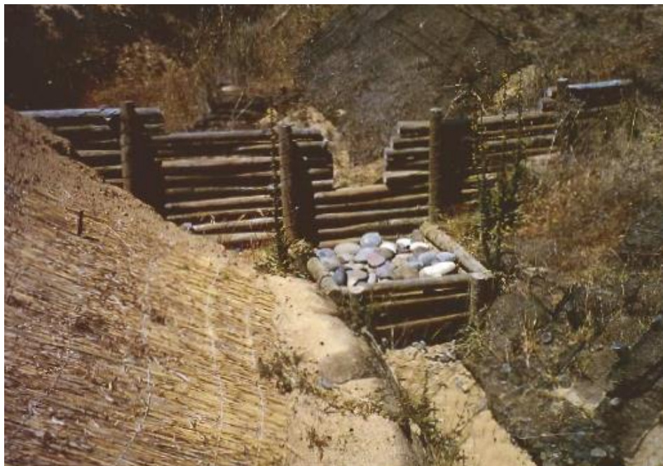
Figura 18. Disposición de disipador en terreno (CONAF, 1998).
