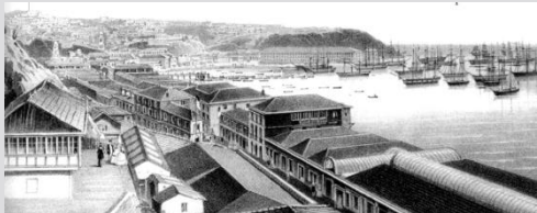
Vista desde tejados en la calle Esmeralda,
