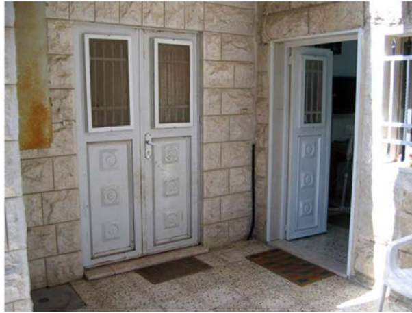
Figura 5.42: Vestíbulo de viviendas palestinas
