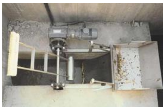
Figura 7: Rejilla de limpieza mecánica con peine giratorio. (Lozano, 2012).
