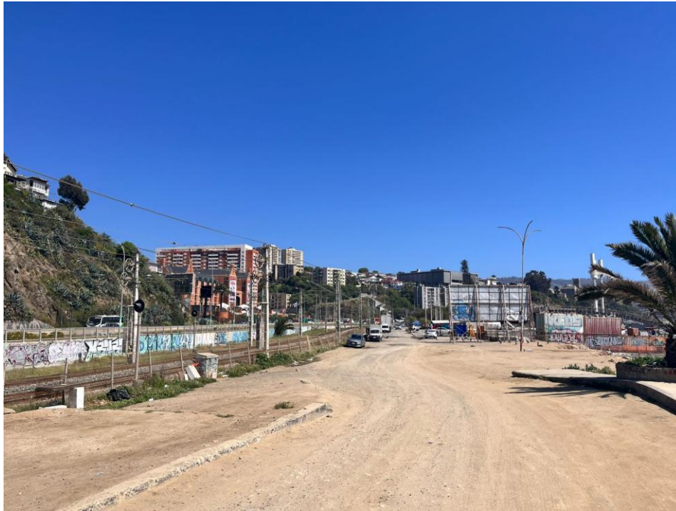
Figura 4-9 Fotografía Avenida Escuadra Libertadora, inicio de tramo B.
