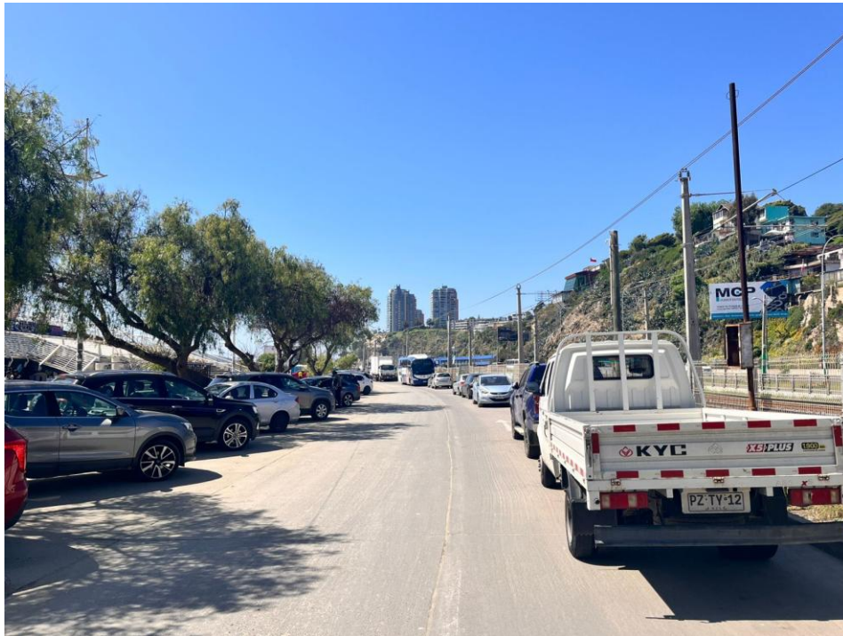
Figura 4-8 Fotografía Avenida Escuadra Libertadora, inicio de tramo A Ciclovía Conectiva Avenida España.
