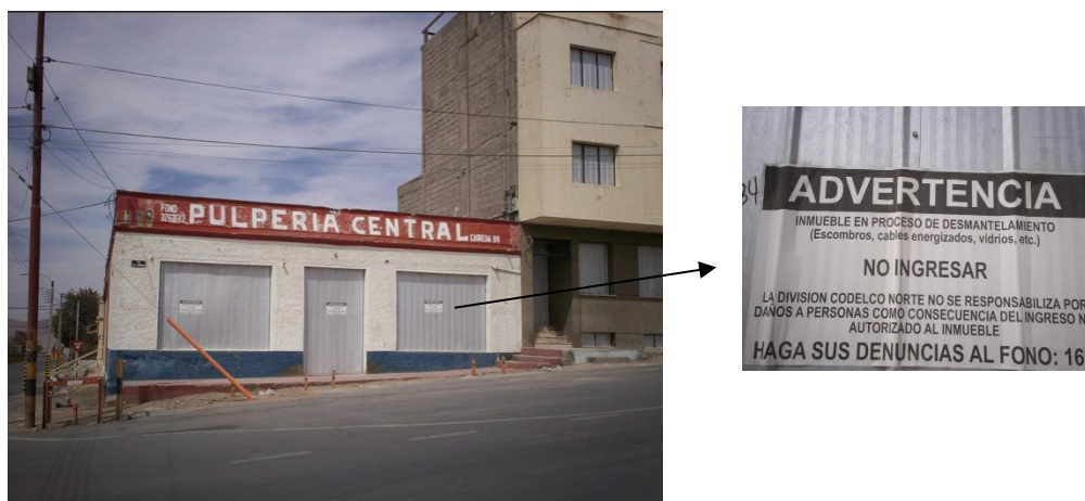
Figura 28. Clausura y prohibición de paso
