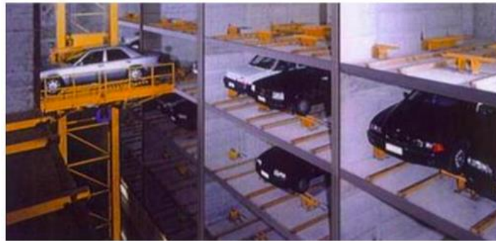
Ilustración 2. 13 Sistemas de traslación vertical y horizontal simultánea PXD
