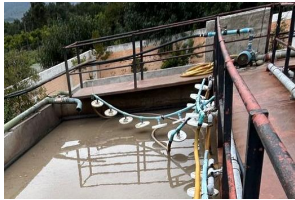
Imagen 6.17 – Reactor fuera de funcionamiento por mal anclaje de difusores y difusores en mal estado
