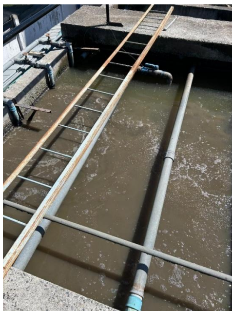
Imagen 9.7 – Tanque de Aireación
