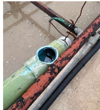
Imagen 6.18 – Tuberías del sedimentador secundario de la línea 1 dañadas
