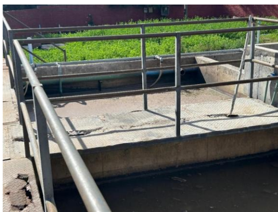
Imagen 7.3 – Pasarela sector de estanque de aireación y sedimentadores secundarios
