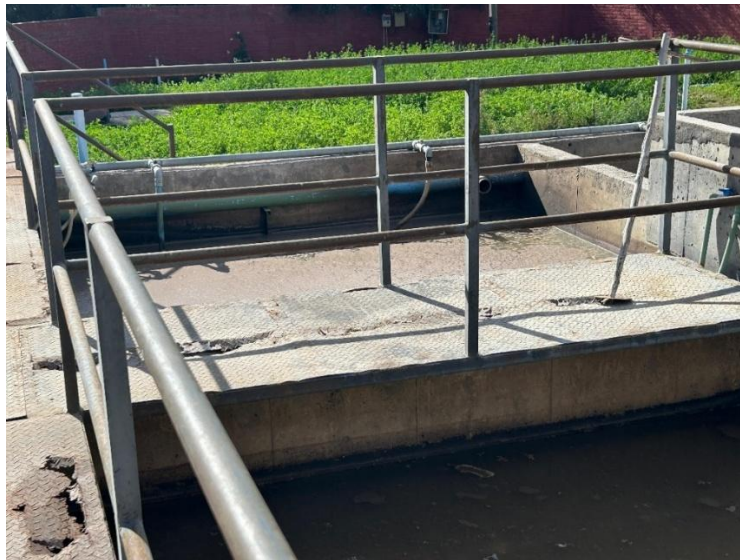
Imagen 3.3 – Pasarelas sector de Estanques de Aireación y Sedimentadores Secundarios
