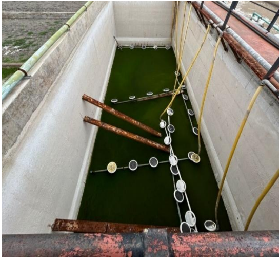
Imagen 6.17 – Reactor fuera de funcionamiento por mal anclaje de difusores y difusores en mal estado
