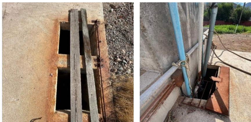
Imagen 5.16 – Acceso de sedimentador primario y acceso de estación elevadora
