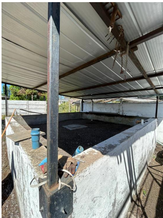
Imagen 9.5 – Cancha de secado y cámaras de gruesos y finos de PTAS El Porvenir
