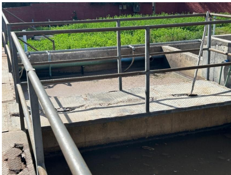
Imagen 2.2 – Pasarelas sector de Estanques de Aireación y Sedimentadores Secundarios
