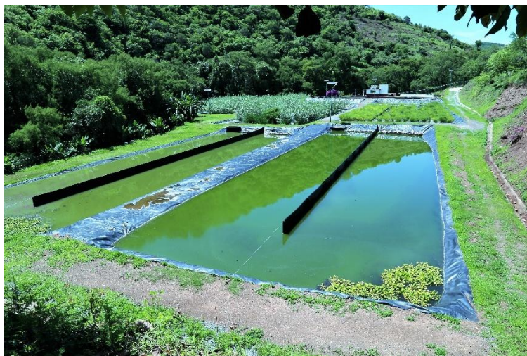
Imagen 3.3 – IMTA laguna de estabilización, Acamixtla. Fuente: [10]
