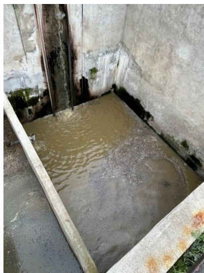
Imagen 6.8 – Sedimentador Primario y características del líquido
