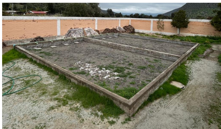
Imagen 6.14 – Canchas de secado de lodos
