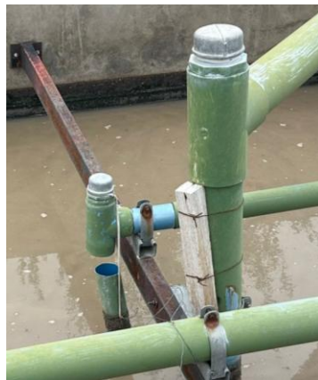
Imagen 6.18 – Tuberías del sedimentador secundario de la línea 1 dañadas
