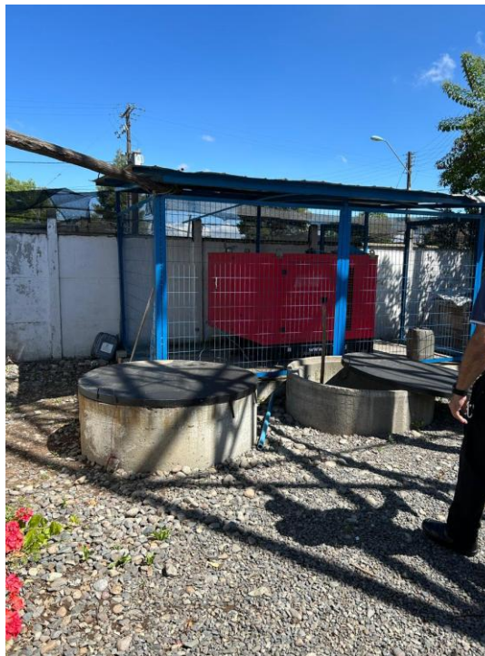
Imagen 9.5 – Cancha de secado y cámaras de gruesos y finos de PTAS El Porvenir
