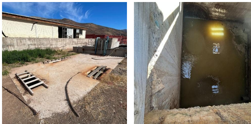
Imagen 5.6 – Sedimentador primario y características del líquido
