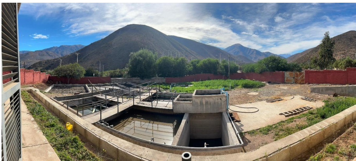
Imagen 5.4 – Planta de tratamiento de lodos activados de La Ñipa
