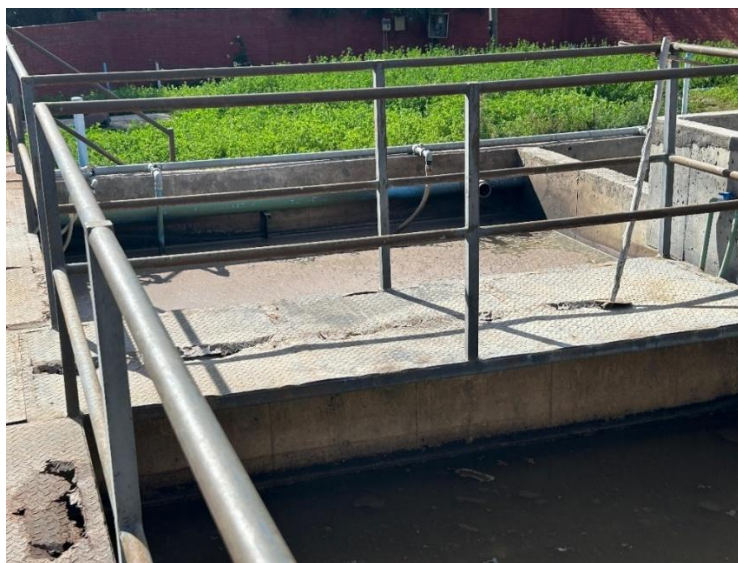
Imagen 4.1 – Pasarelas sector de Estanques de Aireación y Sedimentadores Secundarios
