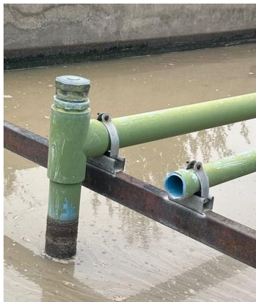
Imagen 6.18 – Tuberías del sedimentador secundario de la línea 1 dañadas
