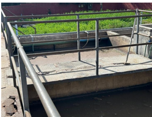
Imagen 5.17 – Pasarelas de planta de tratamiento
