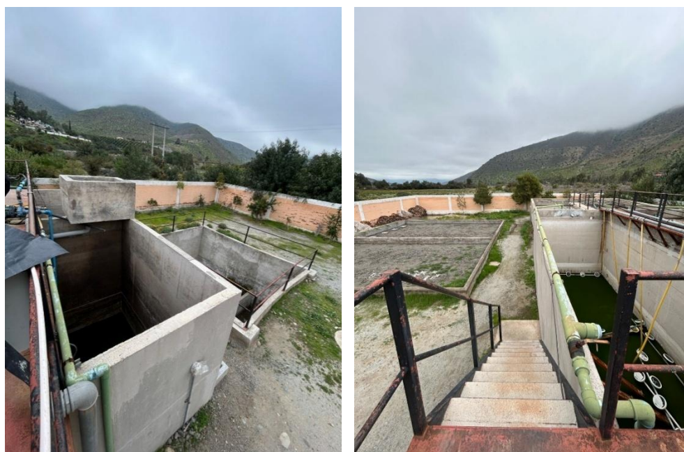
Imagen 6.4 – Planta de Tratamiento en base a lodos activados de Hierro Viejo
