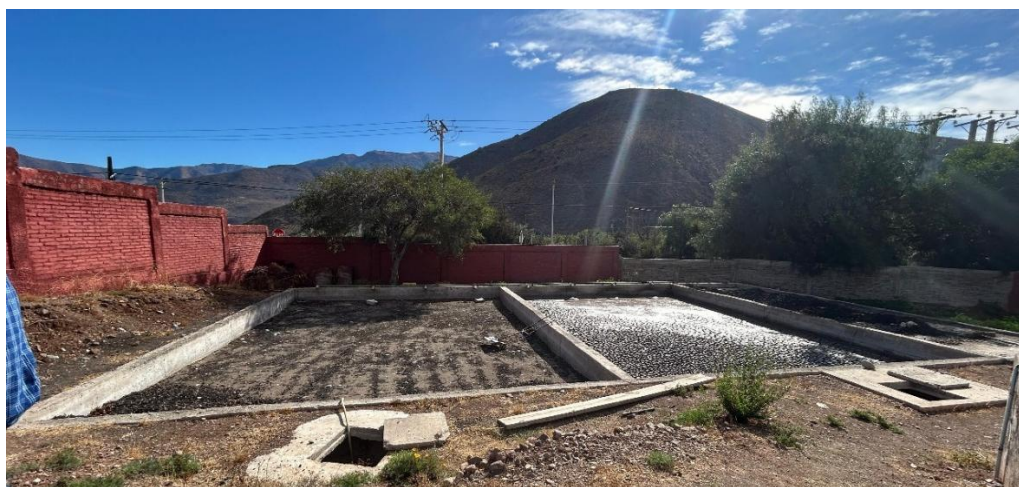
Imagen 5.11 – Canchas de secado de lodos
