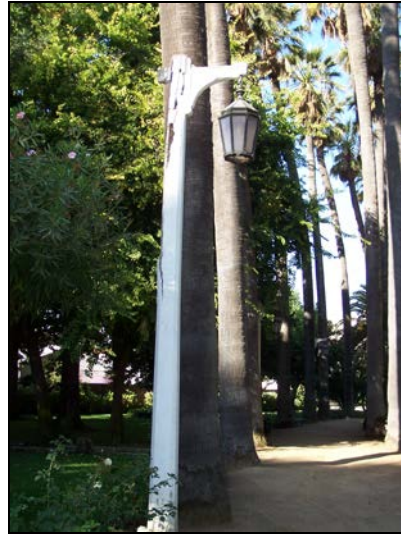
Imagen 3.139: Luminaria, Farol de una columna.
