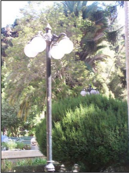
Imagen 3.142: Luminaria, Farol de cuatro focos de iluminación (hacia abajo).
