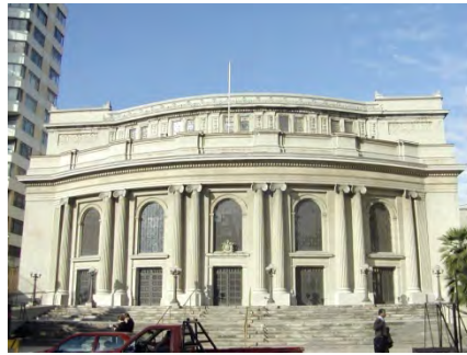
Fotografía N°4: Teatro Municipal de Viña del Mar, Monumento Nacional (D.E.43572009)
