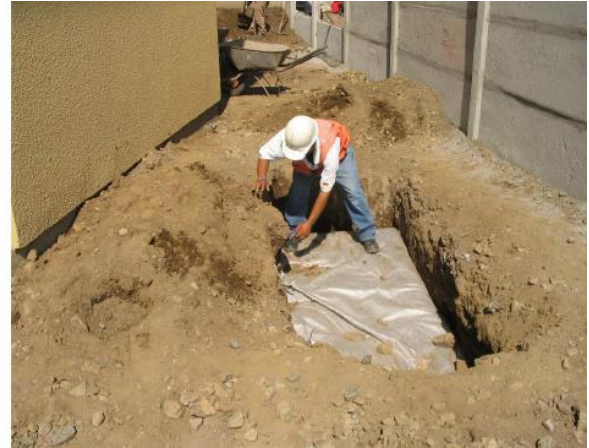
Figura 2.5- Imagen referencial proceso de envolver el cubo dren. Fuente: Ficha Técnica e Instalación Cubo Dren CST maquinarias.
