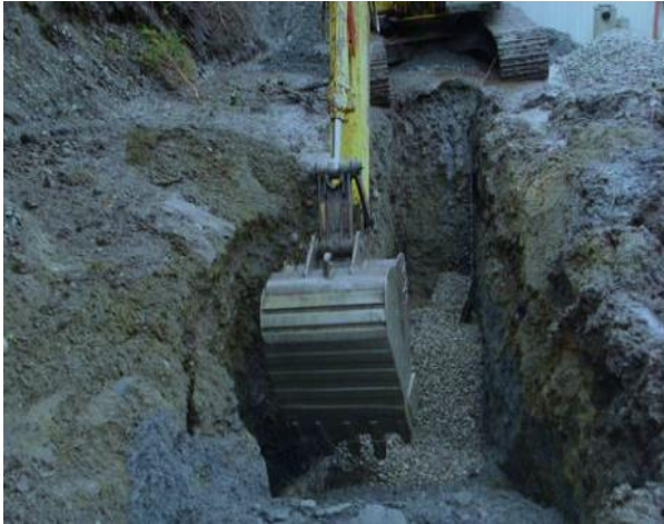
Figura 2.3- Imagen referencial proceso de nivelación. Fuente: Ficha Técnica e Instalación Cubo Dren CST maquinarias.
