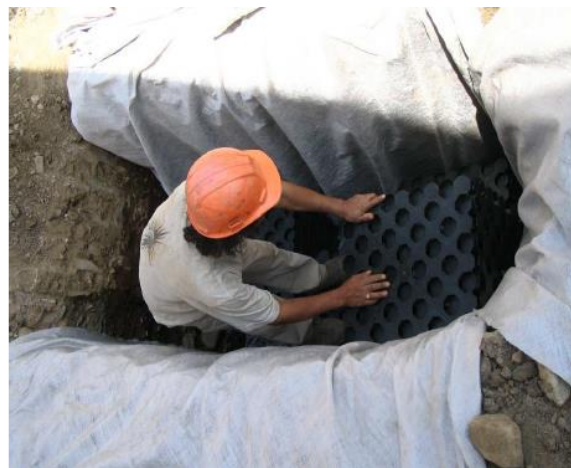
Figura 2.4- Imagen referencial proceso de colocación del geotextil e instalación de cubo dren. Fuente: Ficha Técnica e Instalación Cubo Dren CST maquinarias.
