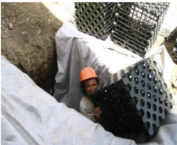
Figura 2.4- Imagen referencial proceso de colocación del geotextil e instalación de cubo dren. Fuente: Ficha Técnica e Instalación Cubo Dren CST maquinarias.
