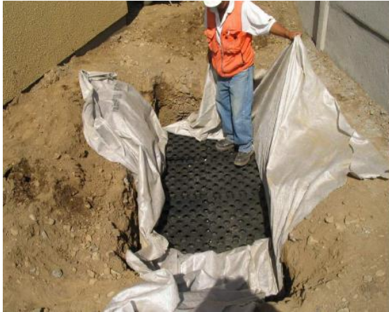
Figura 2.5- Imagen referencial proceso de envolver el cubo dren. Fuente: Ficha Técnica e Instalación Cubo Dren CST maquinarias.
